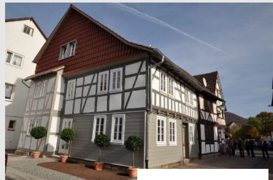
Musterhaus Wanfried nach der Sanierung
