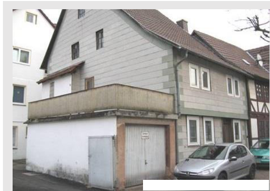
Musterhaus Wanfried vor der Sanierung
