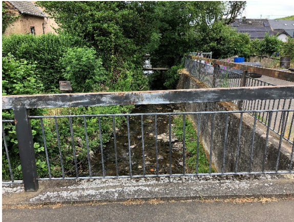
Abbildung 45: Außenanlage der Freiwilligenfeuerwehr am Bach (Fotos: Neuland-Ienken GmbH, 2023)
